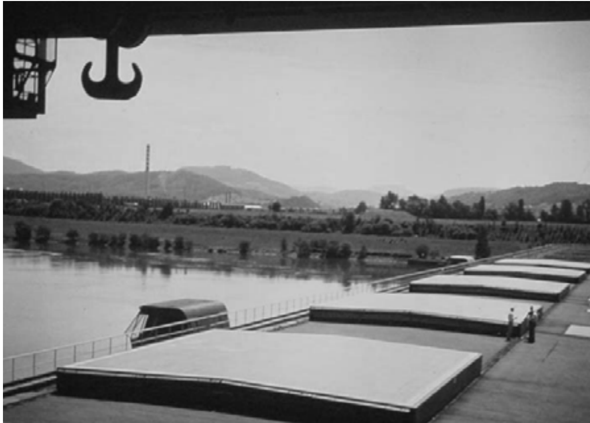
Oberlichtdächer des Rheinkraftwerk Säckingen AG, Bad Säckingen, 1975.
