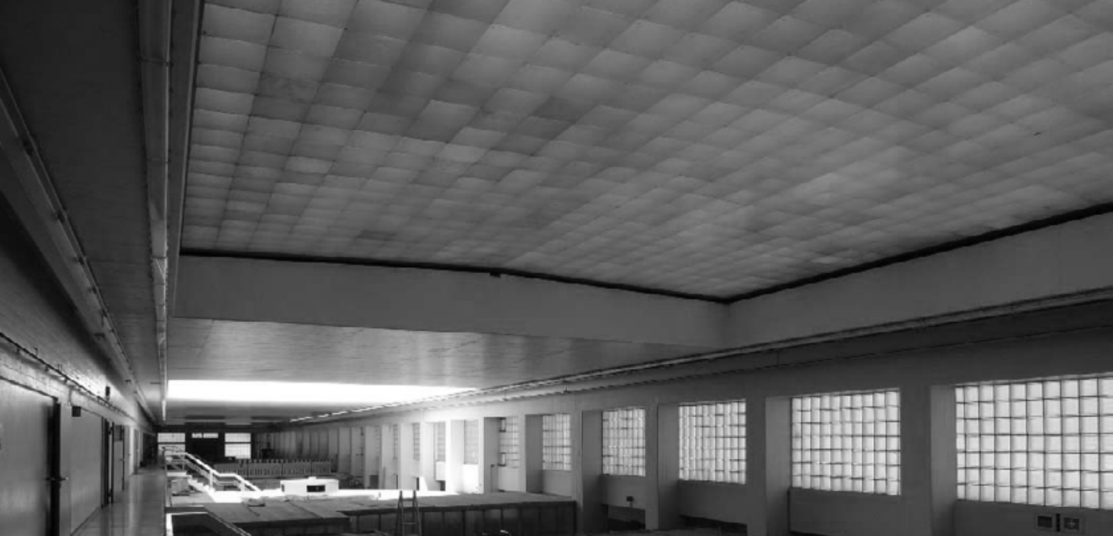
Die Turbinenhalle mit den verschiebbaren Oberlichtern.
