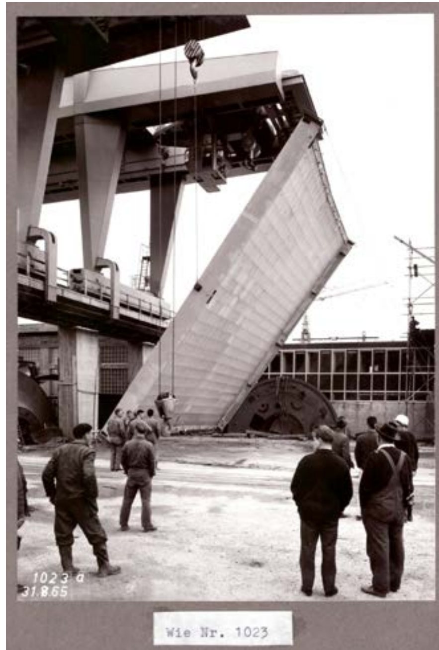
Der erste Belastungstest – ein Oberlicht wird gewendet.
