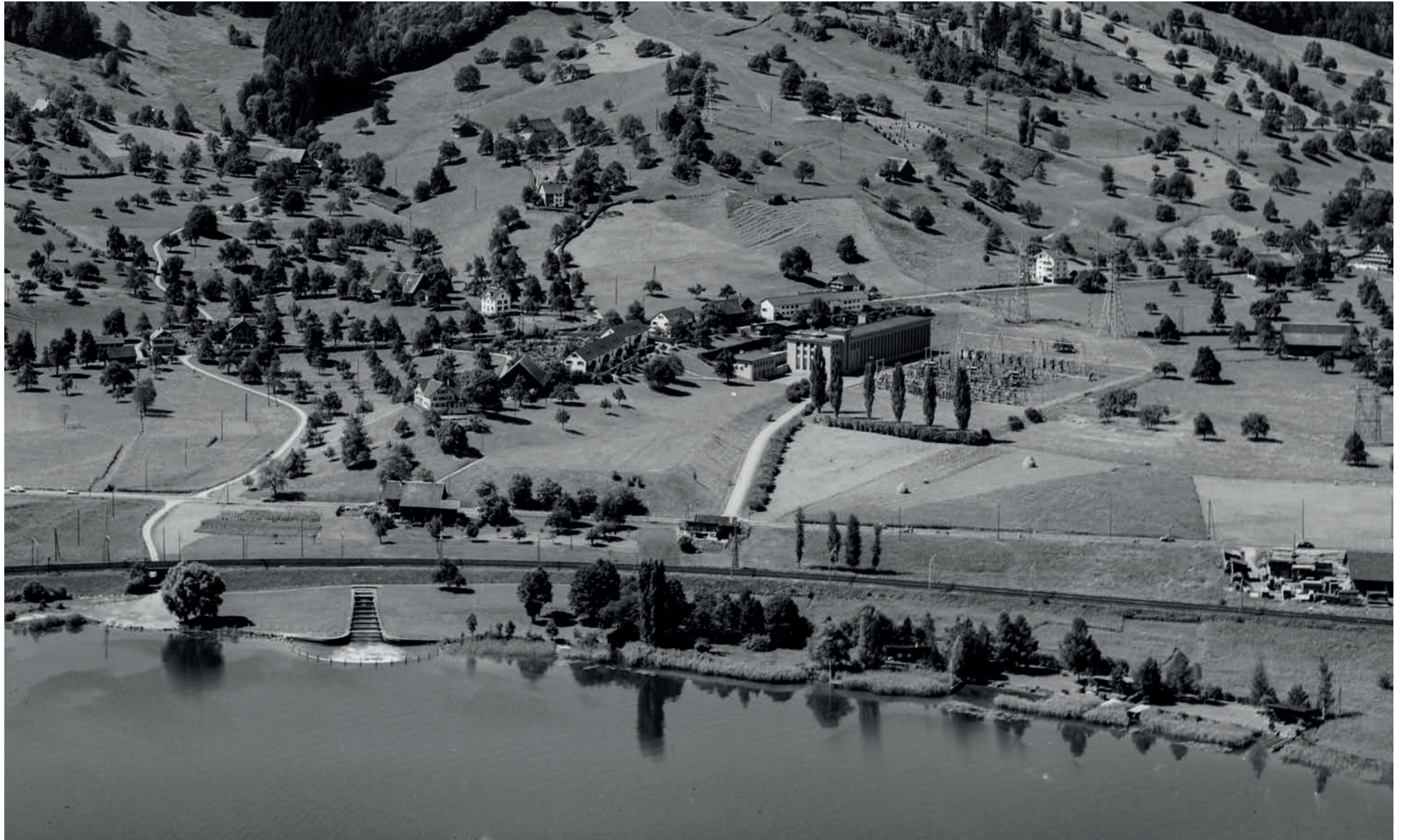
Die Kraftwerkszentrale (Maschinenhaus) in Altendorf, mit Transformationsanlage im Freien sowie Mündung des 400 m langen Unterwasserkanals in den Zürichsee am 2.8.1954.
