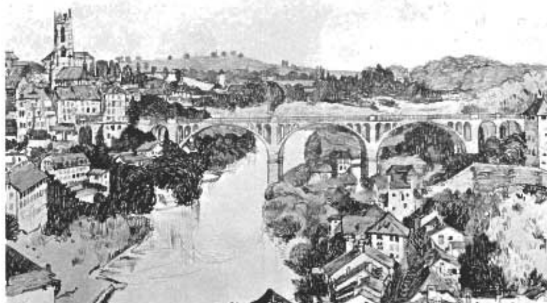
Projet en béton armé. Système Melan. Devis: 1'000'000 Fr.
