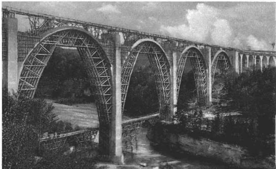
Ci-dessus: L'état des travaux à mi mai 1922. Le bétonnage des arcs est terminé.
