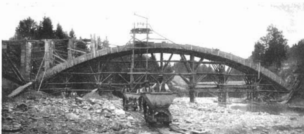
Ci-dessus: Le cintre du pont de Guggersbach en fin de montage.
