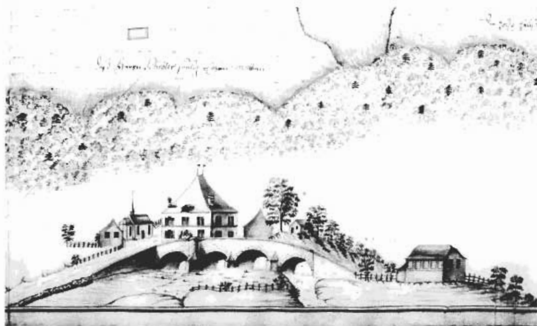
La route Fribourg-Berne traversait la Singine près de Neuenegg. Le pont de bois de 1470 sera reconstruit en pierre en 1539 et 1591, remplacé, en fer en 1893 et en béton en 1968. Illustration tirée d'un plan de 1711 (AEF), photo vers 1890
