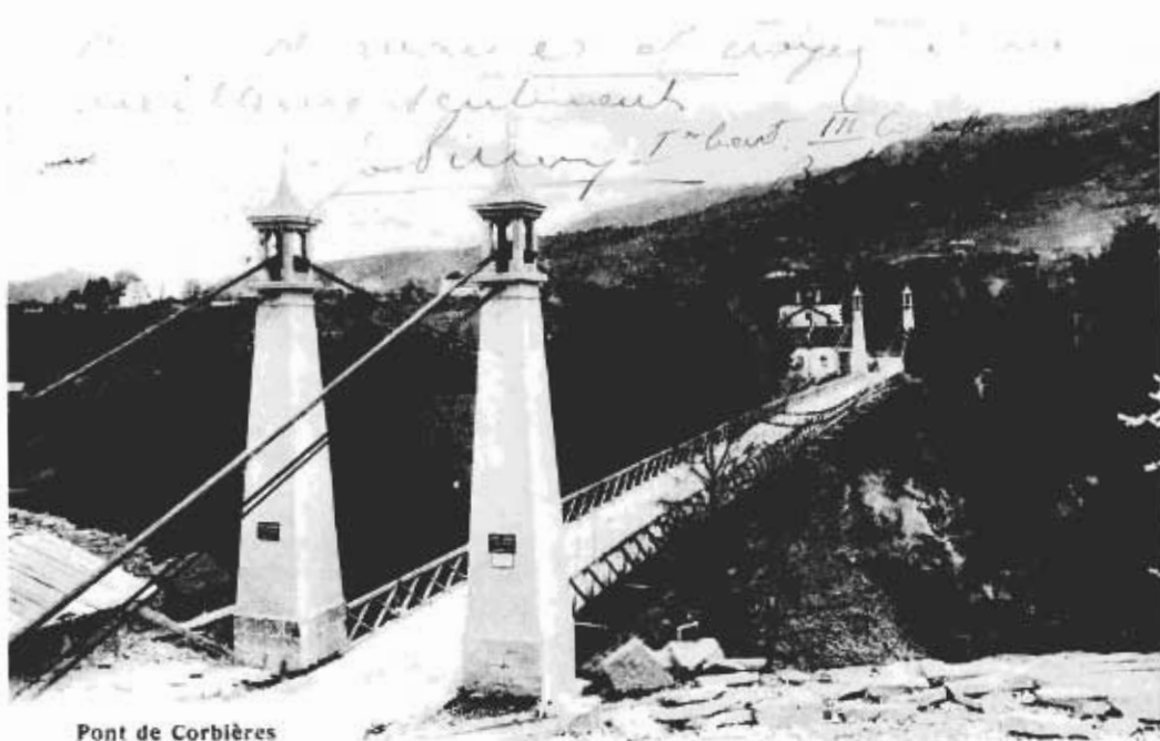
Pont de Corbières
