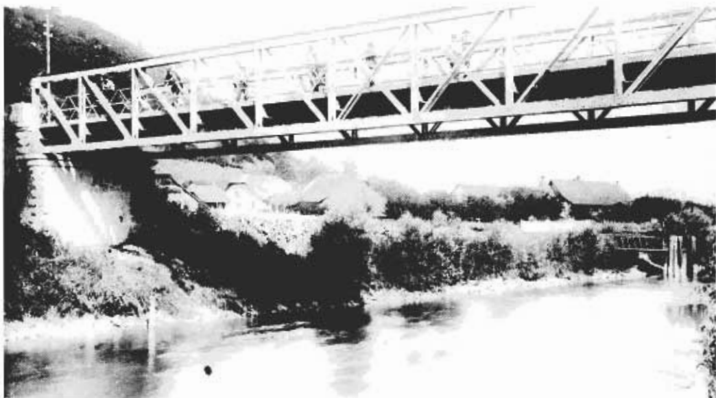
Le pont sur la Broye près de Sugiez, une simple passerelle en poutrelles métalliques avait remplacé en 1874 un pont couvert en bois. Le nouveau pont en béton de 1967 l'avait rendu sans objet. Sa démolition a eu lieu peu après.
