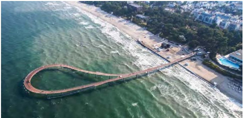
Pier Maritim, Timmendorfer Strand (© S. Stoll, L+W)
