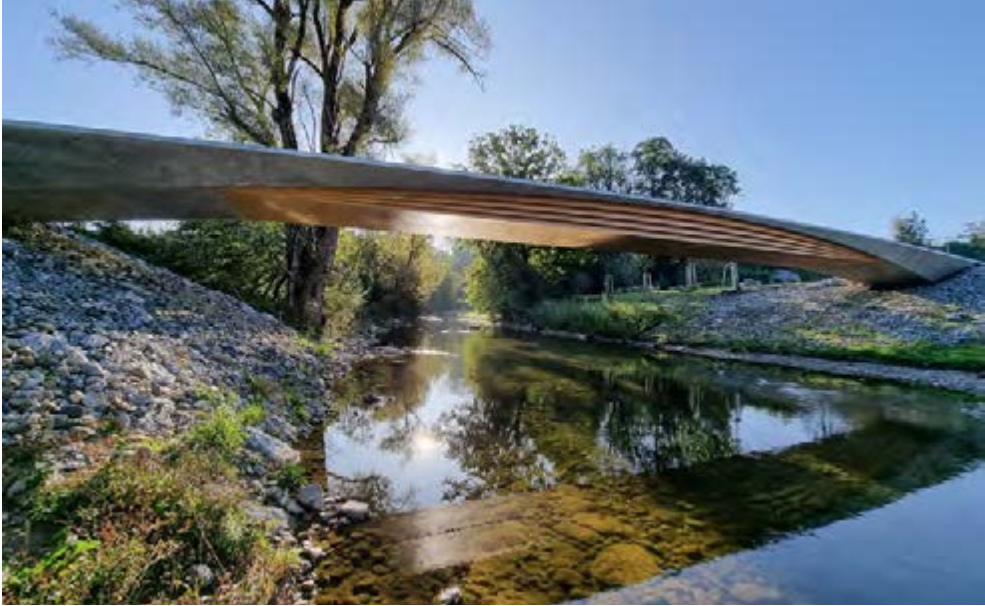
Dornierbrücke, Wangen i. Allgäu, Germany. Photo: Daniel Gebreiter / schlaich bergemann partner
