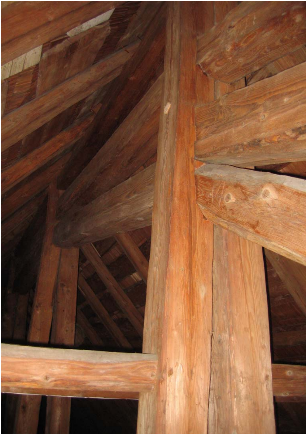
Dachkonstruktion Kirche Brunnadern
