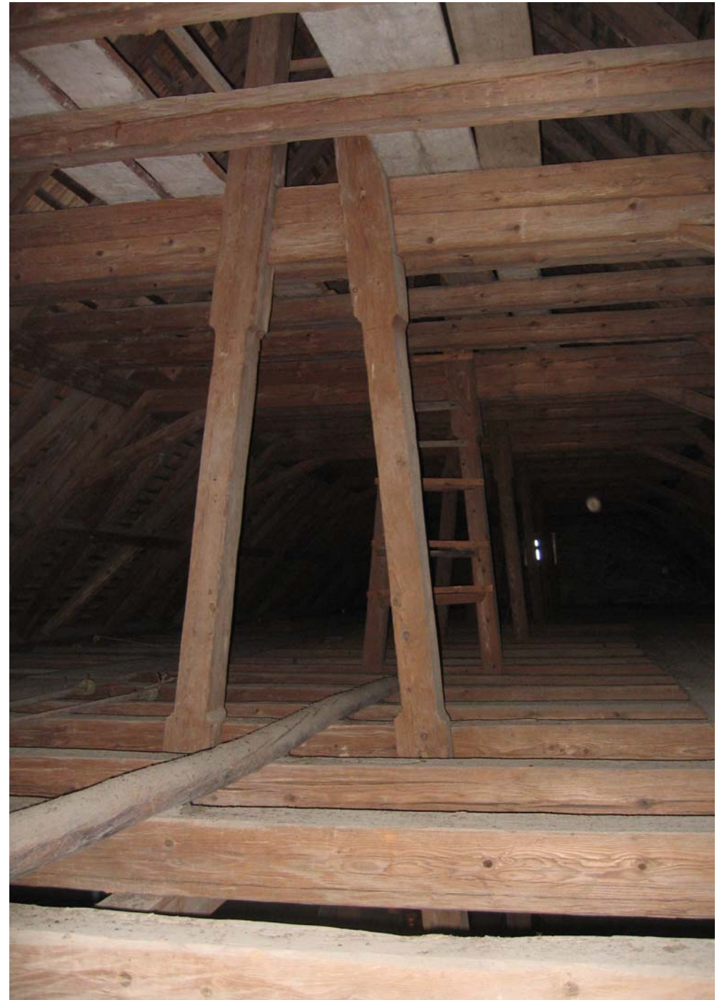
Dachkonstruktion Kirche St. Gallenkappel
